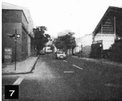
IMAGEN DETERIORO FISICO
