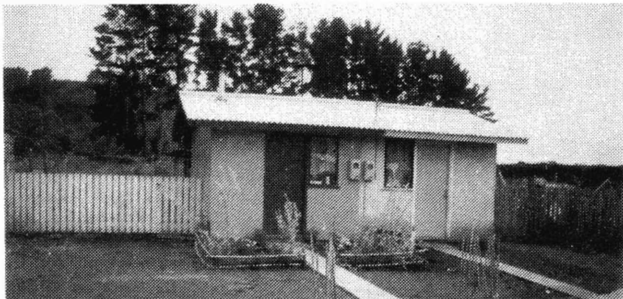
Solución de Viviendas Progresivas pareadas, en asentamiento El Bosque (comuna de Vilcún, Localidad El Cajón, IX región). Primera etapa de 12 mts 2
